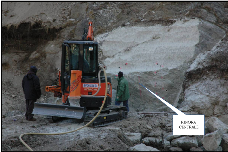
Preparazione di una rinora centrale a "V"
