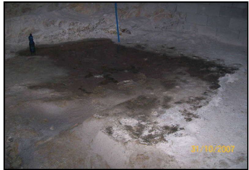
Scavo in roccia di vano ascensore in una villa a Portorotondo con esplosivi classici
