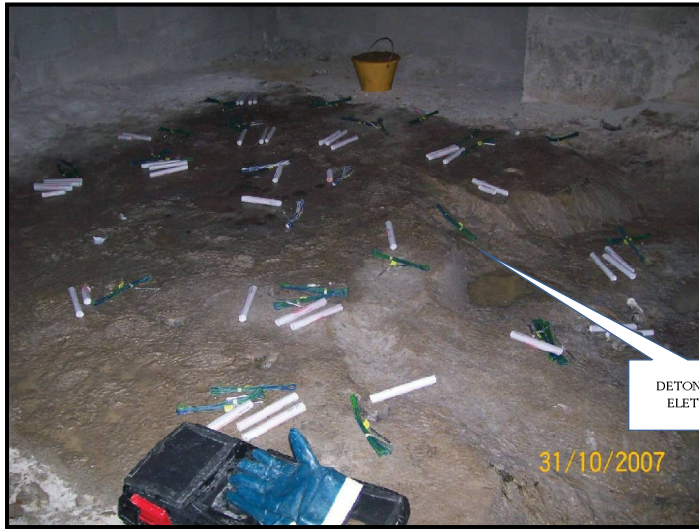
Perforazione e caricamento di una rinora a "V" nello scantinato
