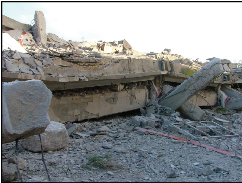
IMPACCHETTAMENTO DEI SOLAI A "SANDWICH"
