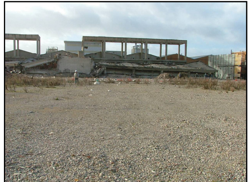
DETON SRL: demolizioni con esplosivo
