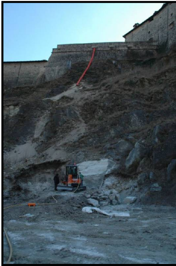
Apertura di una galleria di accesso sotto il castello di Exiles in Val di Susa (TO) con dispositivi Non - detonanti
