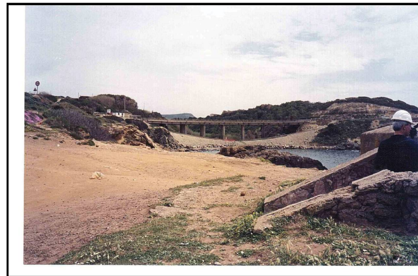
Vista del ponte prima dello sparo
