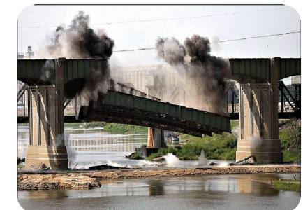
Abbattimento del Topeka Boulevard Bridge
