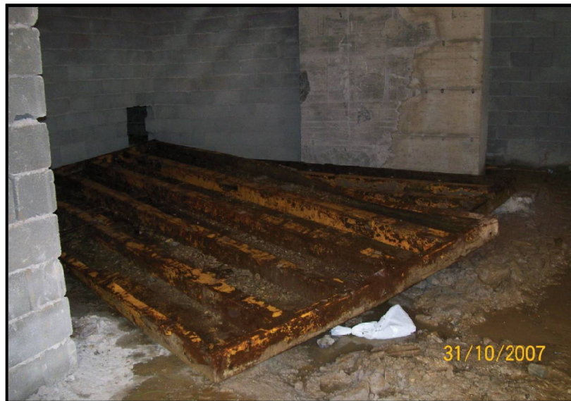
Copertura delle zone minate con pesanti lamieroni.
