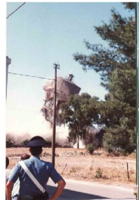
DEMOLIZIONE DI UN SERBATOIO PENSILE A CHILIVANI (SS)
