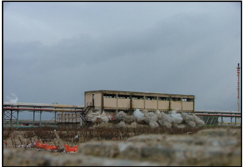
Lancio di corrente con l'esplositore- 2
