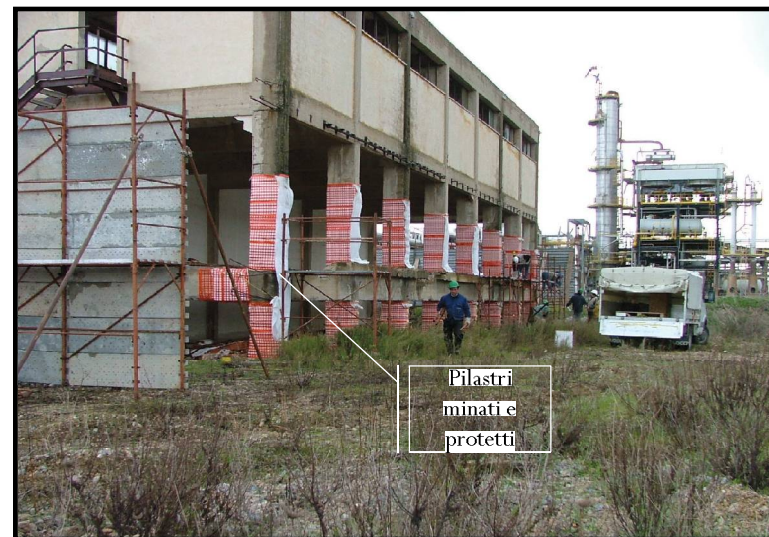
DEMOLIZIONE CON RIBALTAMENTO LATERALE - CABINA ELETTRICA SYNDIAL - ENICHEM PORTOTORRES (SS)
