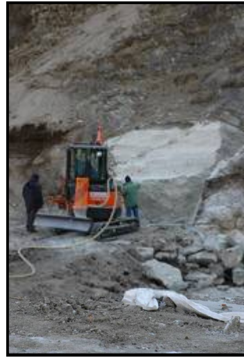
Apertura di una galleria di accesso sotto il castello di Exiles in Val di Susa (TO) con dispositivi Non - detonanti
