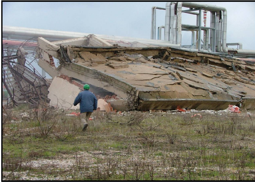
Fase di controllo del materiale abbattuto
