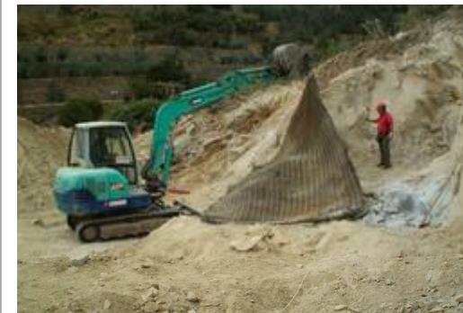
Bordighera : scavo di 500 metri cubi per ampliamento edificio
