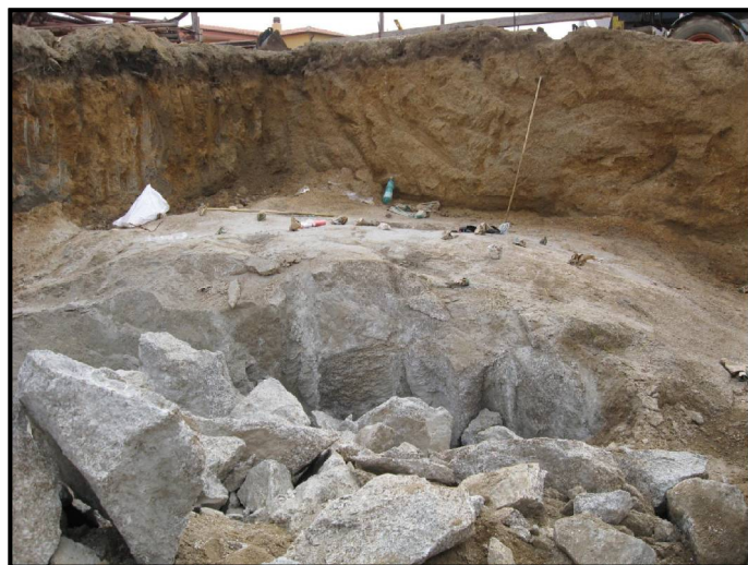
Scavo in roccia ad Arzachena con l'uso di cartucce Non - Detonanti.
